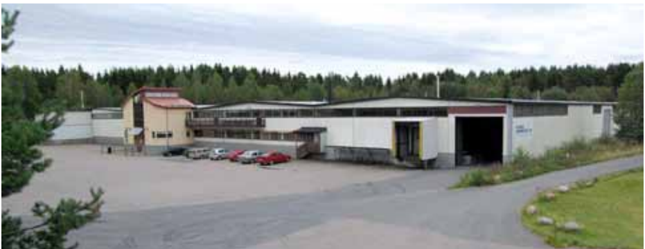
I Sävsjö finns detta lager med omkring 12 000 kvadratmeter under tak.
